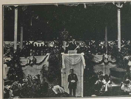
Solemne acto de la colocación de la primera piedra del Palacio de las Repúblicas Americanas.
